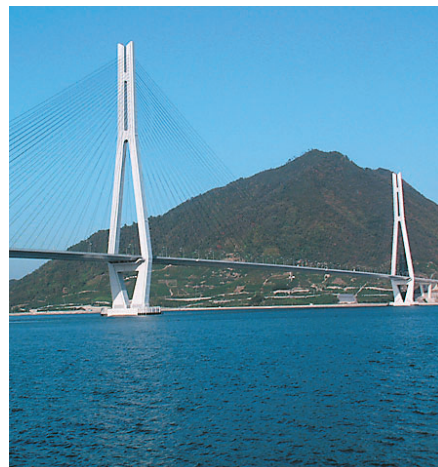
瀬戸内しまなみ海道(多々羅大橋)
