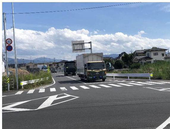
【写真 県道松山空港線（旧空港通り）との暫定取付状況】
