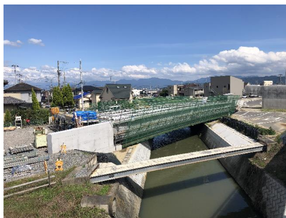
【写真 堂之元川橋梁工事の状況】
