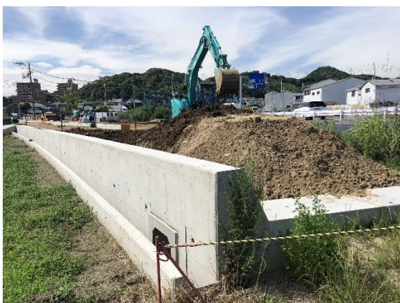
【写真 道路改良工事の状況】
