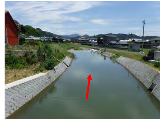
写真 4-14 整備状況 (SP. 900 付近)
