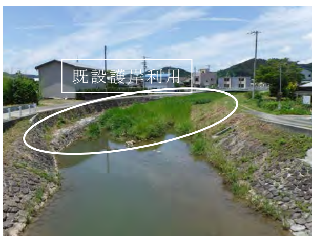
写真 6-1 既設護岸利用箇所
