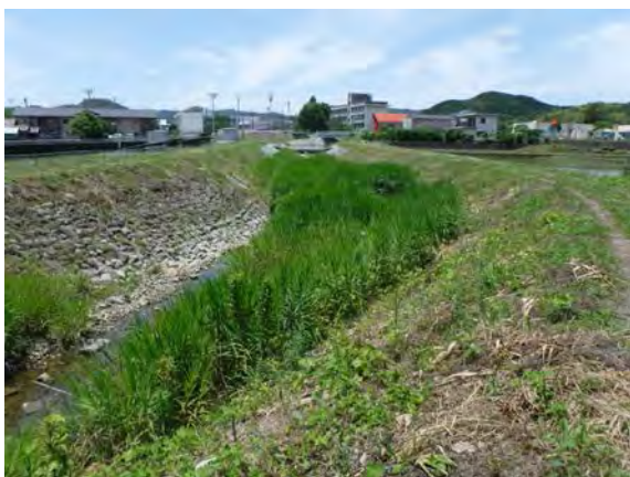
写真 7-1 河川整備状況
