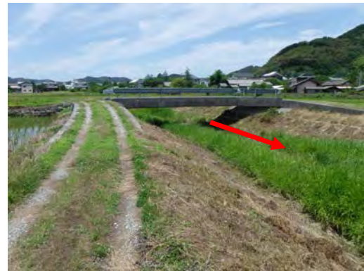
写真 4-2 整備状況 (SP. 200 付近)
