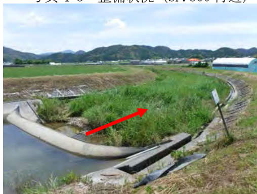
写真 4-5 整備状況 (SP. 400 付近)
