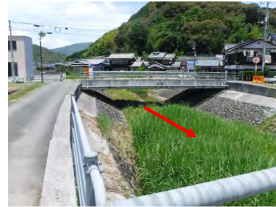
写真 4-10 整備状況 (SP. 700 付近)
