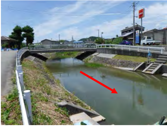
写真 4-7 整備状況 (SP. 600 付近)
