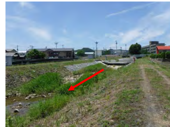
写真 4-12 整備状況 (SP. 900 付近)
