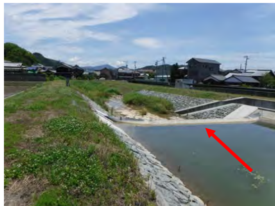
写真 4-13 整備状況 (SP. 900 付近)
