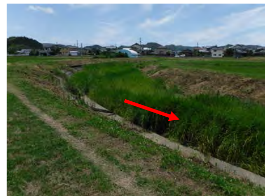
写真 4-4 整備状況 (SP. 300 付近)
