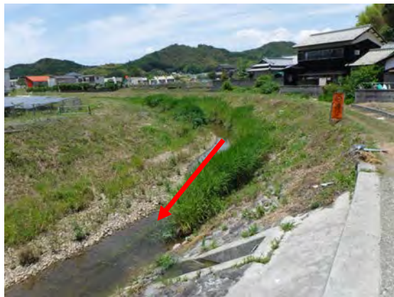
写真 4-11 整備状況 (SP. 800 付近)
