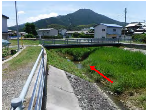
写真 4-9 整備状況 (SP. 700 付近)
