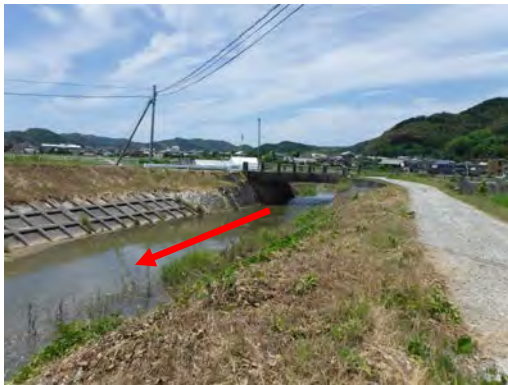
写真 4-1 整備状況 (SP. 0 付近)
