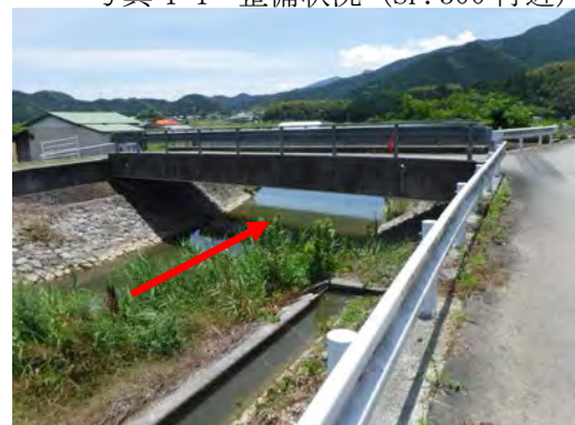
写真 4-6 整備状況 (SP. 500 付近)
