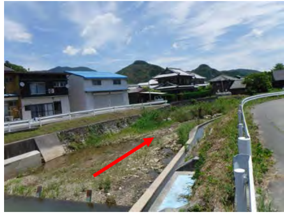
写真 4-8 整備状況 (SP. 600 付近)
