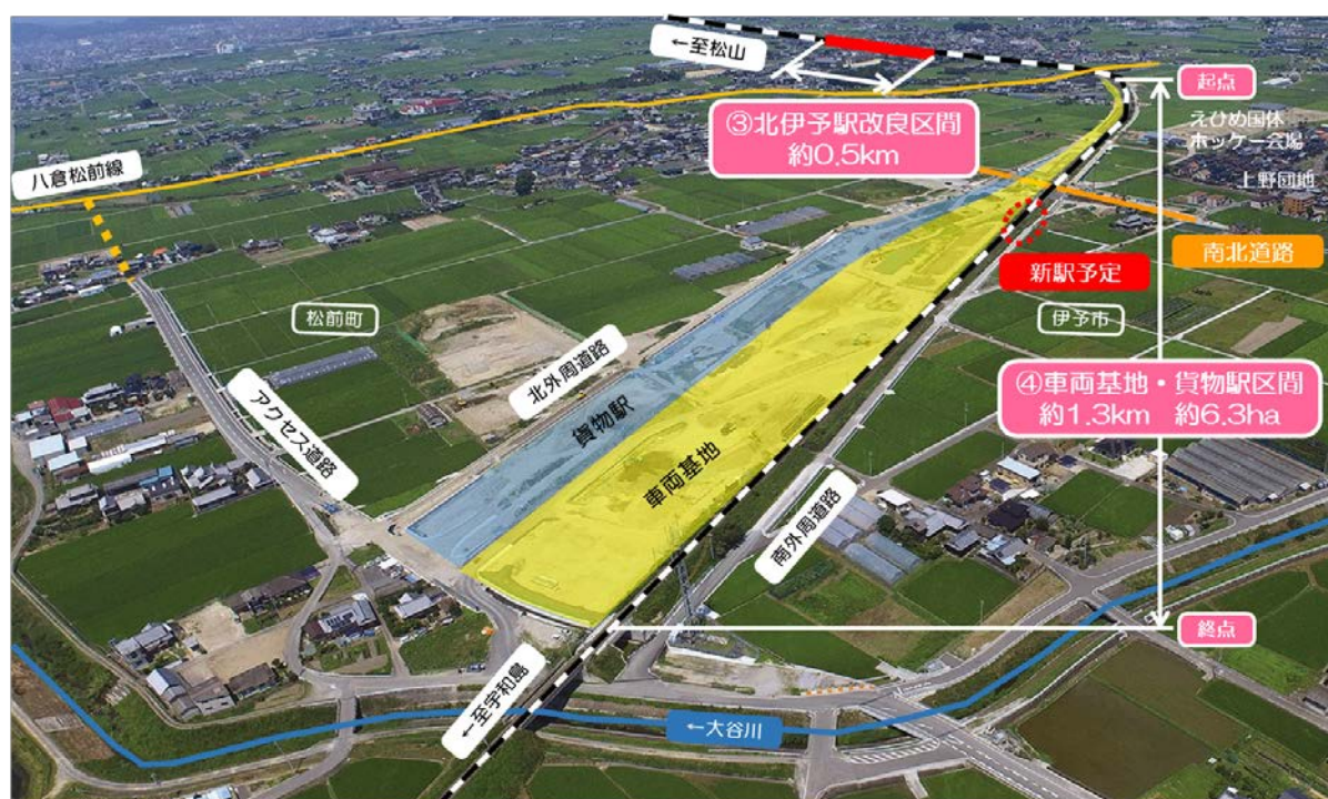
【車両基地・貨物駅区間の航空写真】
