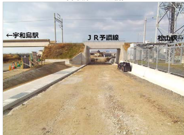
(平松第二架道橋)
