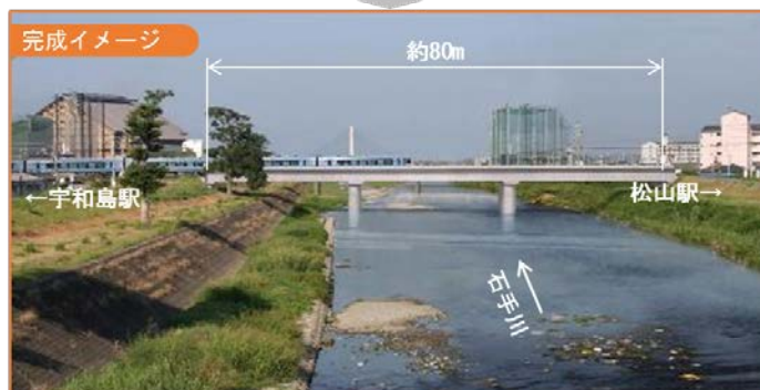
橋梁架替え、掘削・護岸整備
