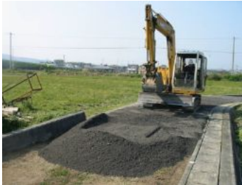
「アッシュストーン」 (施工例)
