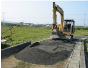
「アッシュストーン」 (施工例)
