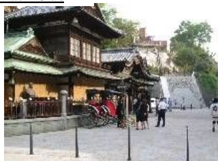
(松山市：道後温泉本館周辺道路景観整備)
