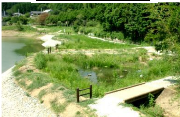
西予市宇和町永長地区ほ場整備
