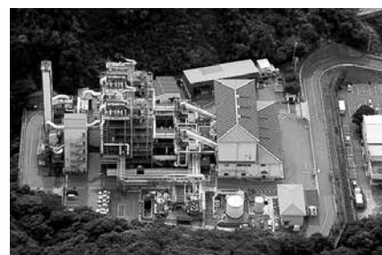
愛媛県廃棄物処理センター
