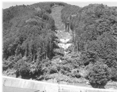
【山地災害跡地への 治山施設整備】
