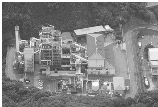
愛媛県廃棄物処理センター
