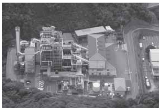
愛媛県廃棄物処理センター
