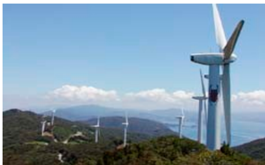
伊方町の風力発電施設
