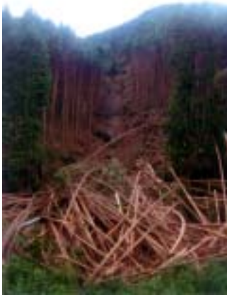
流木等防止山地保全事業 (危険な流木等の除去)
