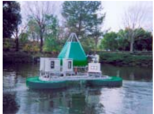
砥部動物園池水質浄化システム
