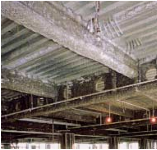
図表 20 吹付け石綿施工部位事例
