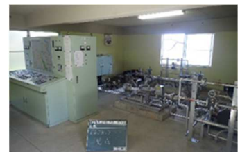
かんがい施設改修状況
