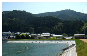
ため池の改修
