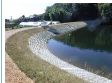
ため池の改修整備
