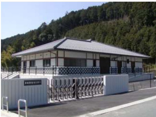
農業集落排水処理施設
