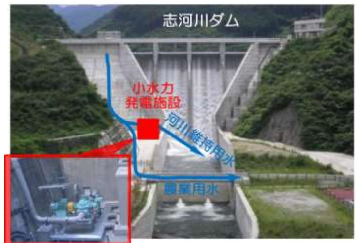
志河川ダムの小水力発電施設
