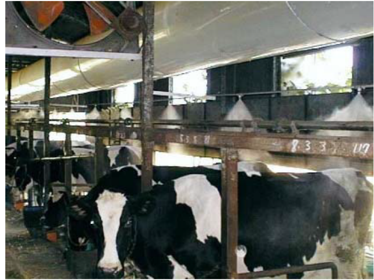
図4. 送風ダクトと細霧を組み合わせた暑熱対策装置
