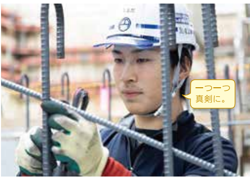
建築中の病院施設の壁となる鉄筋を組み立てています! キレイ・丁寧・美しい仕事を心掛けます。
