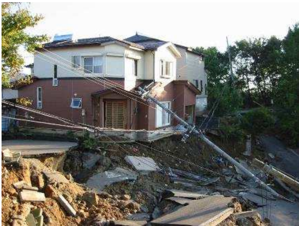
H16新潟県中越地震の被害
