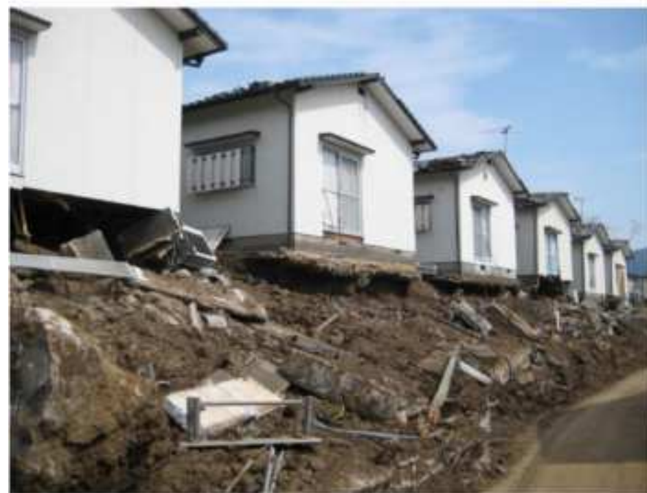
H28熊本地震の被害
