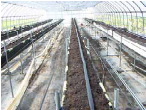
灌水チューブを設置
