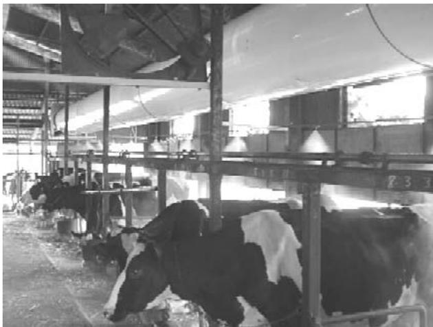
写真2 S氏牛舎に設置したダクト細霧法
