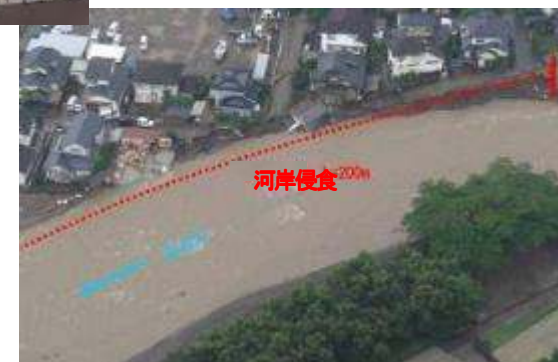
河岸侵食に伴う 家屋倒壊等
