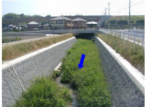
平常時の水量が少ないため、低水路(みお筋)を設置し、魚類等の生息空間を確保。
