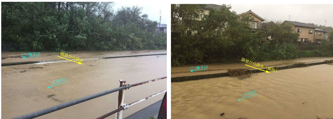
写真 1.3. 平成 30 年(2018 年)台風第 24 号 出水時状況写真 (今治市提供) 「コンクリート背割堤(猿子川)からの中川への越水のみ」
