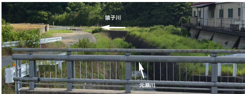
写真 4.1. 元瀬川の合流点付近の河道状況
