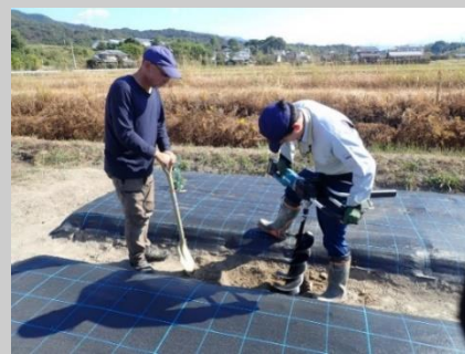
【穴掘り機を用いた排水性改善】
