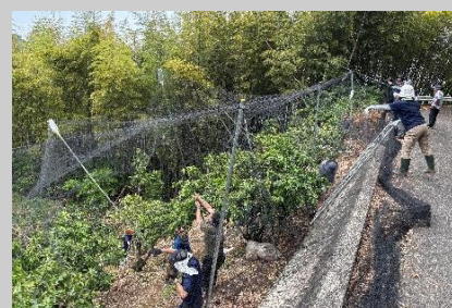
【防鳥施設の設置作業の様子】
