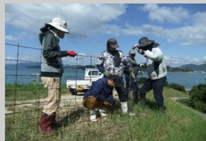
【ワイヤーメッシュ柵の設置実習】
