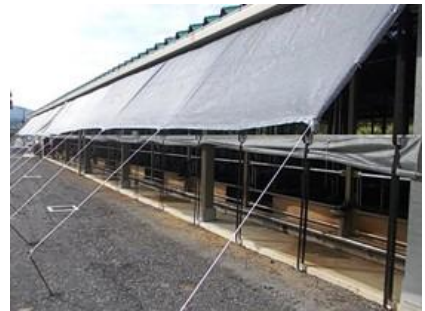
写真1 遮光ネット(寒冷紗)を設置した牛舎
