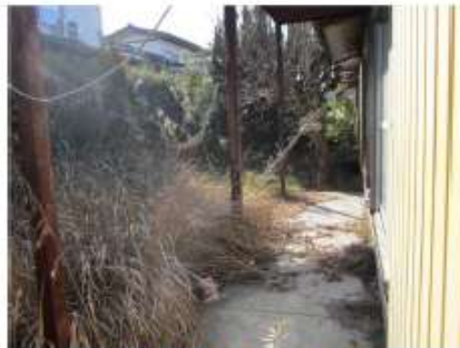
雑草が繁茂した空き家
