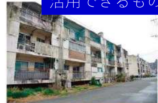
共同住宅の空き家
