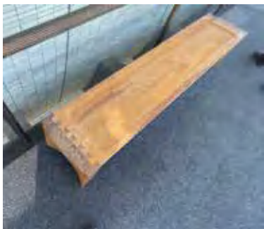
7. 木製ベンチの劣化
