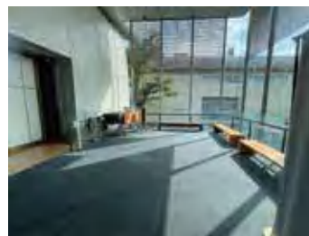
ルーバーによる日射遮蔽 (2025/3/10 14時頃)
