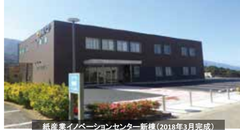
紙産業イノベーションセンター新棟(2018年3月完成)
