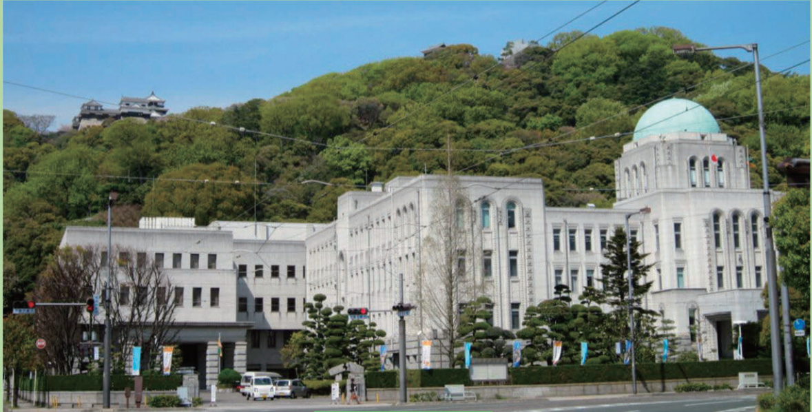
議事堂と県庁本館
