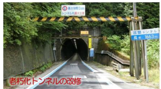
(国)319号法皇トンネル[愛媛県管理] S35年建設/延長1,663m
