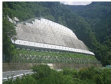
法面防災対策(アンカー工)
