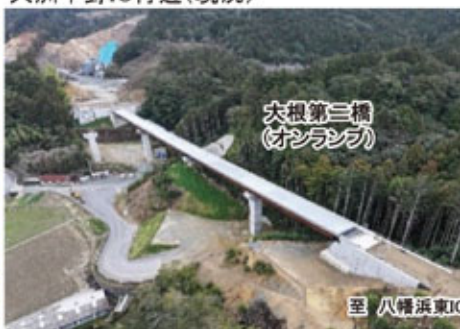
大洲平野IC付近(現況)
