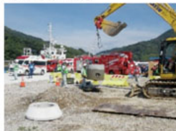
マンホール撤去
