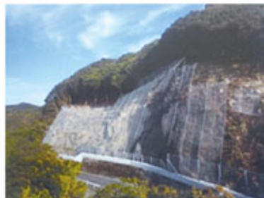
法面防災対策(落石防護工)
