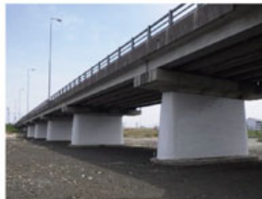
橋梁耐震対策(橋脚巻立工)
