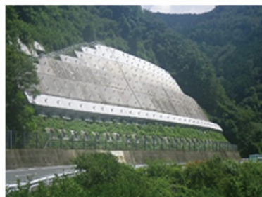
法面防災対策(アンカー工)
