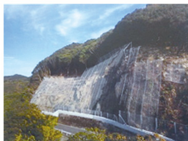
法面防災対策(落石防護工)
