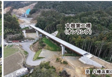
大洲平野IC付近(現況)
