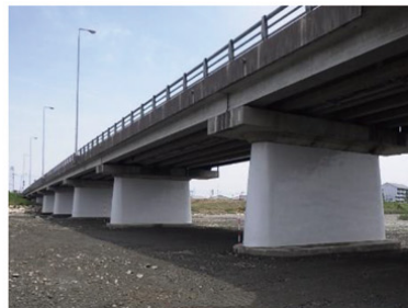
橋梁耐震対策(橋脚巻立工)
