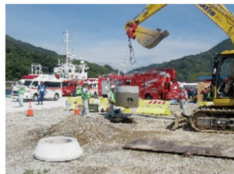
マンホール撤去
