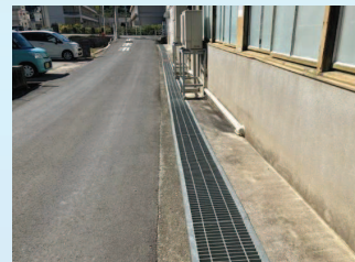
↑ 側溝の整備工事の写真
