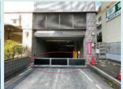
↑水災害に備えた資機材(防水板)の写真
