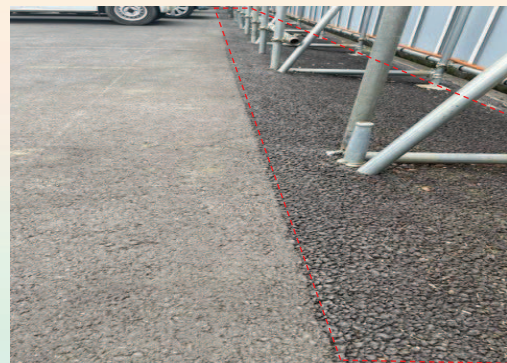
↑透水性舗装の敷設の写真
