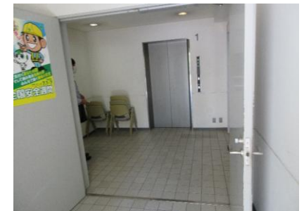
【エレベーター間口】
