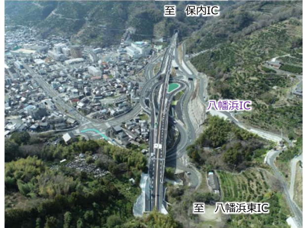
名坂道路～八幡浜道路 八幡浜IC付近（八幡浜市）令和5年3月25日開通
