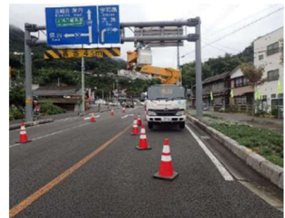
【門型標識定期点検】 一般県道 八幡浜保内線(八幡浜市)
