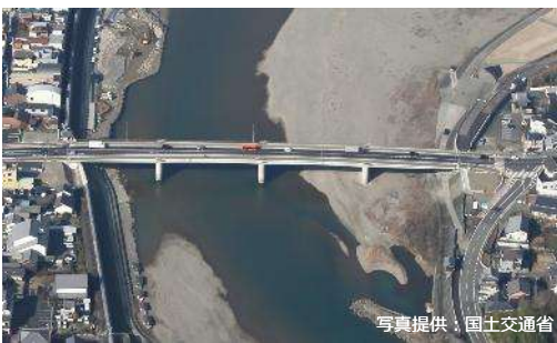
【肱川橋梁架替】 一般国道56号(大洲市大洲～中村)
