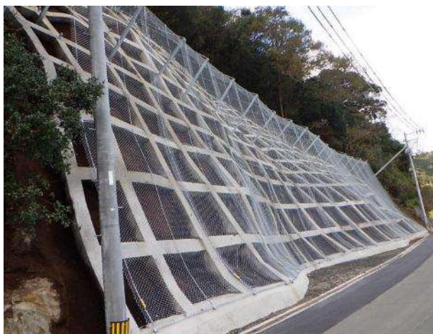
【施工事例（法面防災）】一般国道378号（八幡浜市） 〔法枠工+ロックネット〕
