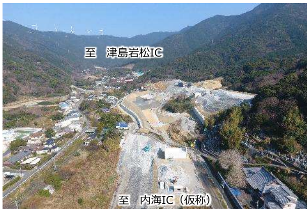
津島道路 工事状況 (宇和島市上畑地) 写真提供: 国土交通省
