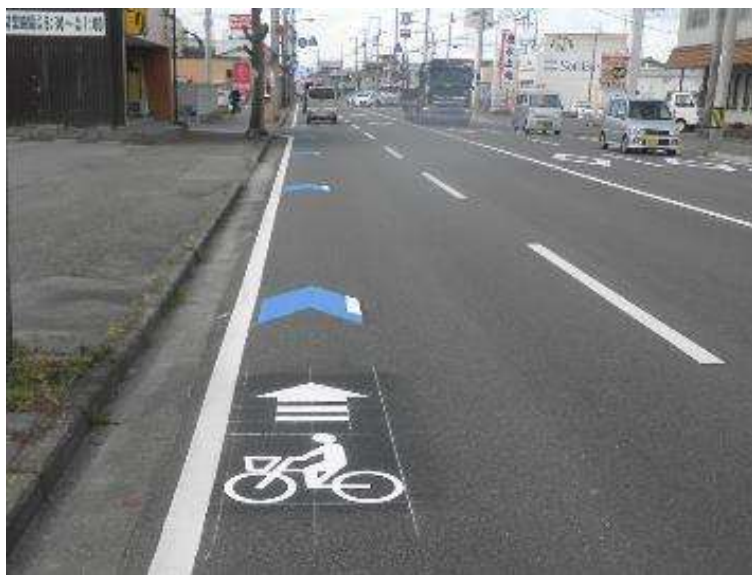
【施工事例（路面標示による自転車通行位置の明示）】 主要地方道 壬生川新居浜野田線（新居浜市）
