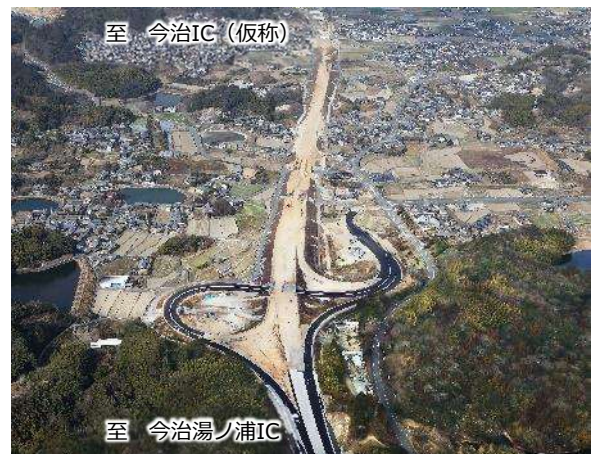
今治道路 今治朝倉IC 工事状況 (今治市) 写真提供: 国土交通省
