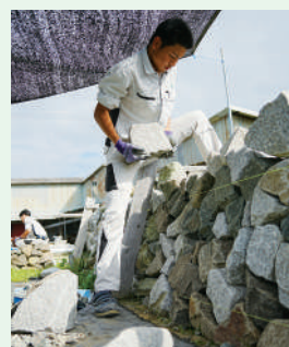
石積みをする様子
