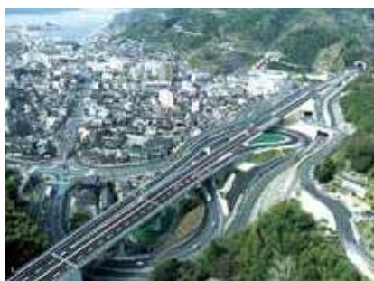
大洲・八幡浜自動車道
