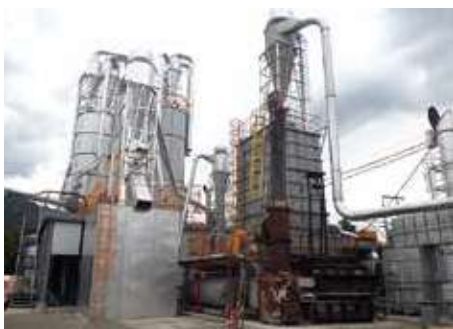
木質バイオマス発電所
