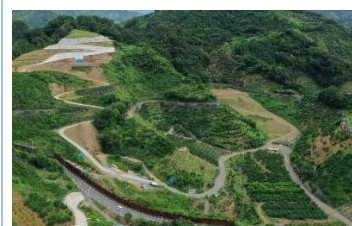
再編復旧工事中
