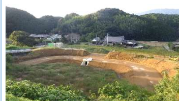
ため池改修工事中
