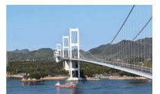
来島海峡大橋
