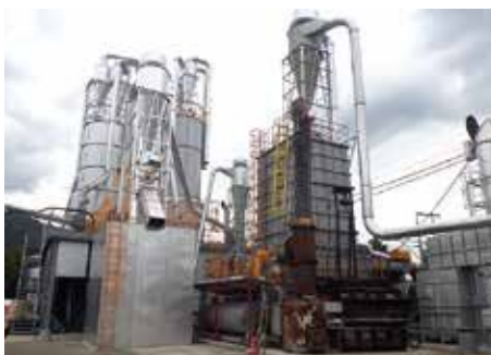
木質バイオマス発電所
