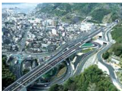
大洲・八幡浜自動車道
