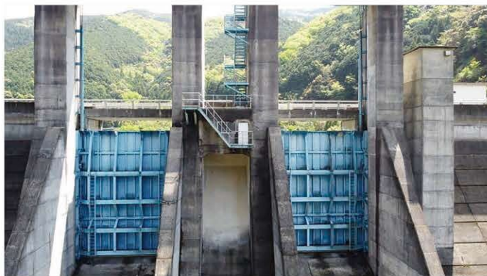
ゲートルーラ改良工事（山財ダム）
