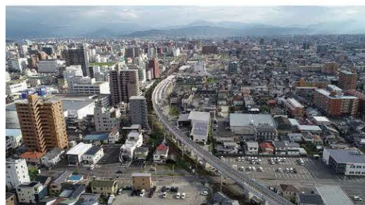
JR松山駅付近連続立体交差事業
