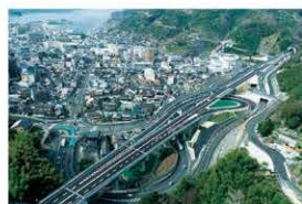
大洲・八幡浜自動車道
