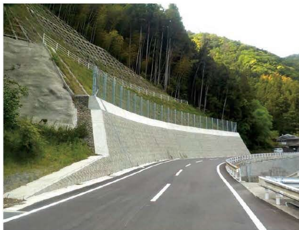
（国）380号 緊急輸送道路の整備
