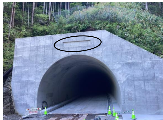
銘板設置前の状況(松山側坑口)
