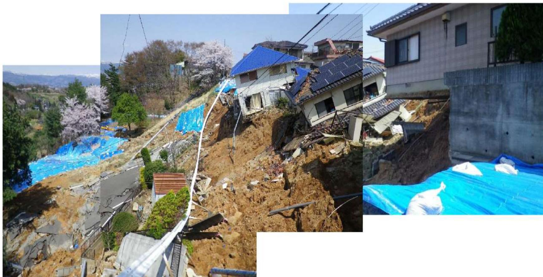
写3-11 のり面の崩壊の例
