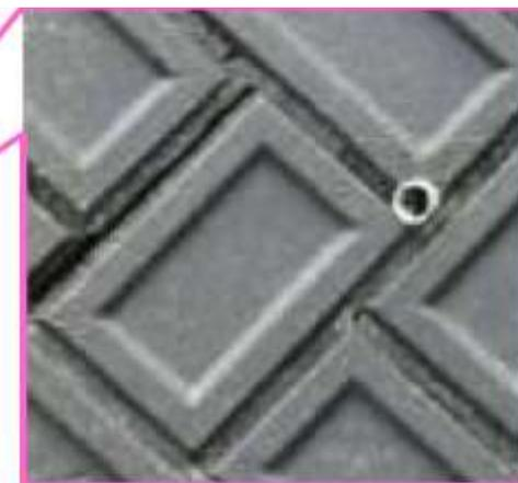
写3-1 擁壁の水抜穴規格の不具合の事例
