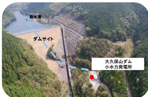
県営かんがい排水事業で建設された大久保山ダムの水位差を利用して発電を行っています。小水力発電施設整備事業で発電機等を整備し、平成30年10月から発電を開始しています。
