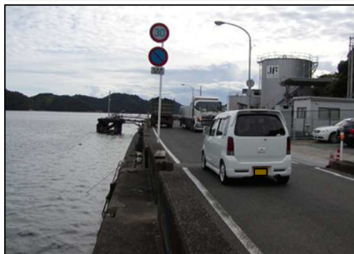
現状（大型車両の増加により離合が困難）
