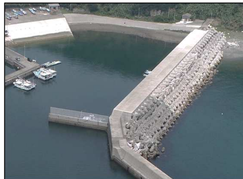
北防波堤（R3完成）
