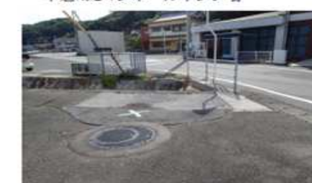
【 管路設備／下水道圧送管PEφ100L=169m、下水道管VUφ150L=325m（管路統合：平瀬 平瀬No.2マンホールポンプ場 平瀬
