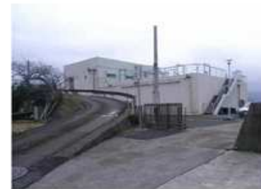
① 建屋外観
