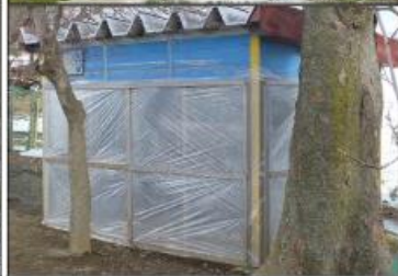
寒冷対策を兼ね、シートを 張った野生動物の侵入防止対策
